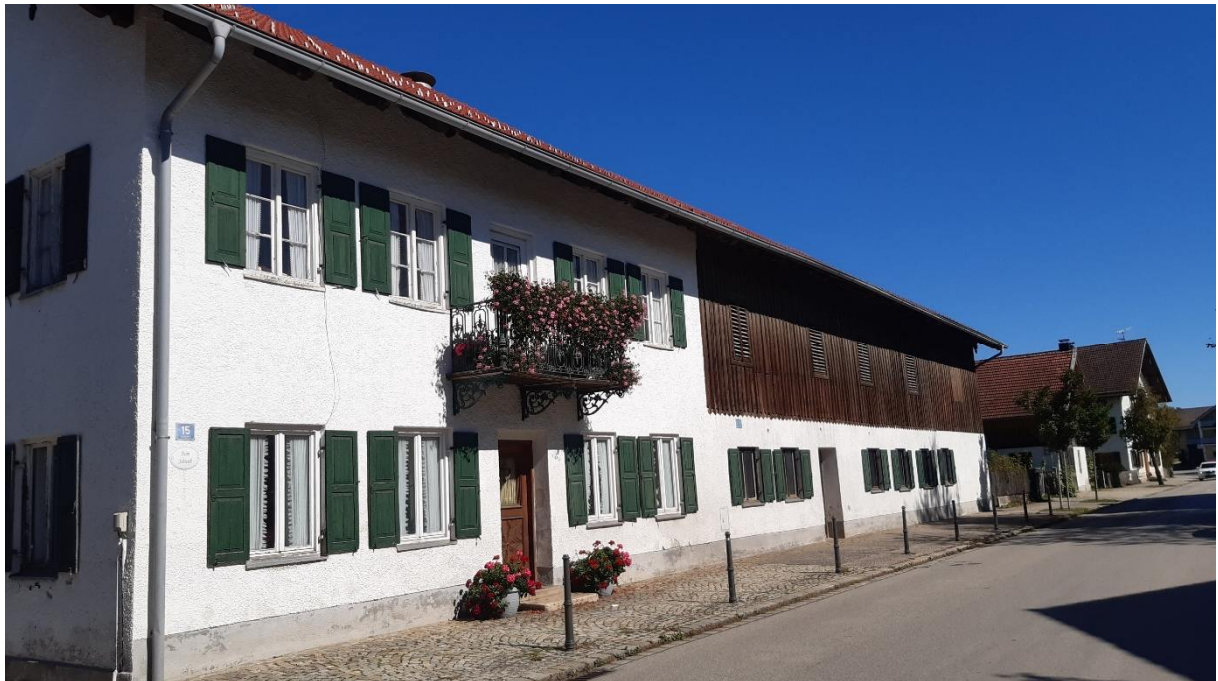
Abb.8: Westliches Gebäude „Beim Schwab“, Hofmark 15
