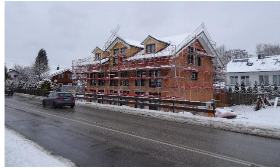
Abb. 6: Kochler Straße, Neubau auf 67a bis 67c
