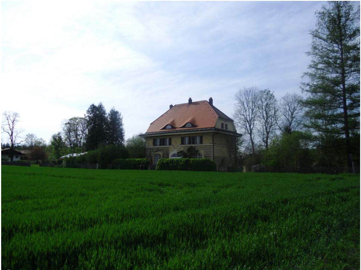
Abb. 6 Blick auf das im Untersuchungsgebiet vorhandene denkmalgeschützte Gebäude (Quelle: AGL, Mai 2012)
