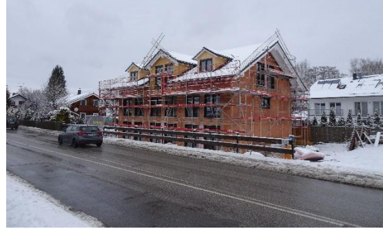
Abb. 6: Kochler Straße, Neubau auf 67a bis 67c
