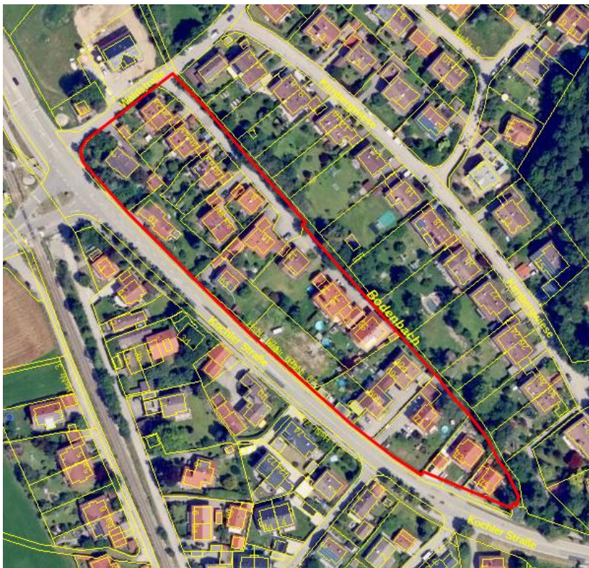
Abb. 2: Luftbild des Planungsgebiets (rot umrandet)
